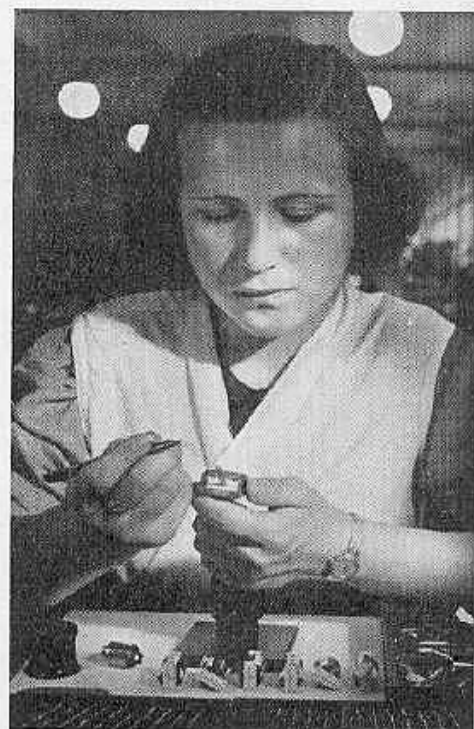
Samenstelling van een Telefunken-radiolamp.
